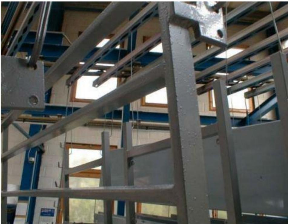
Die Gründe hierfür liegen u.a. in dem Vorhandensein von Weißrost, im Austreten von Wasserstoff, CO<sub>2</sub> und / oder SO<sub>2</sub> aus der Verzinkung, in einer zu dicken Zinkschicht (> 80µm), in der Zusammensetzung des Stahls (zu hoher Si-Anteil), in zu langen Verweilzeiten im Zinkbad, in der Badführung usw.
